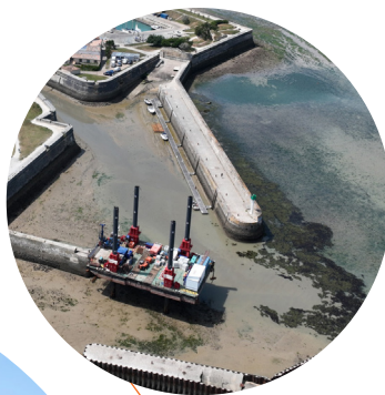
Remplacement de l'épi de protection du port Saint-Martin-de-Ré (17) (2020 - en cours)
